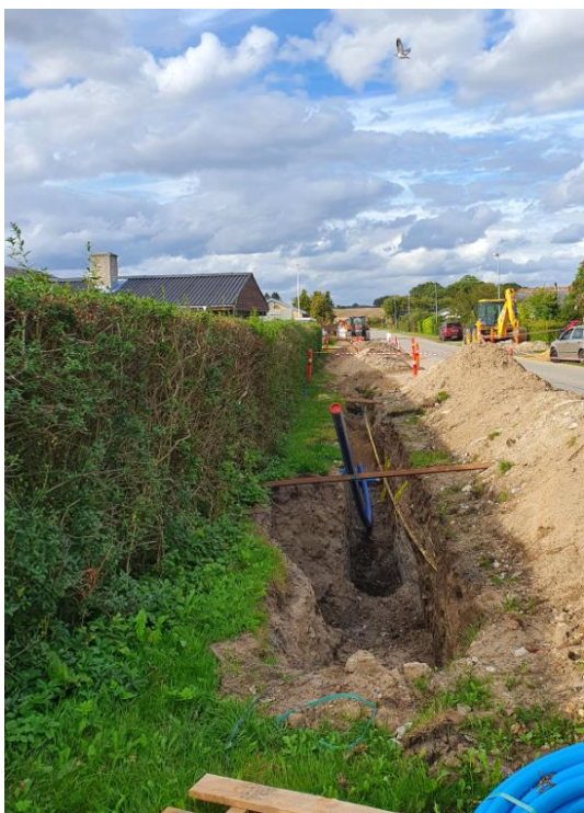
Erik Pedersen A/S i gang med omlægning af vandledninger på Ønsbækvej.
