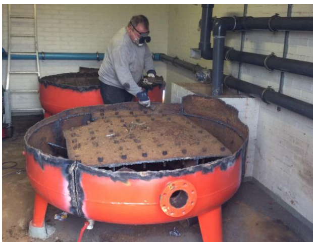
Nedbrydning af de gamle filtre.
